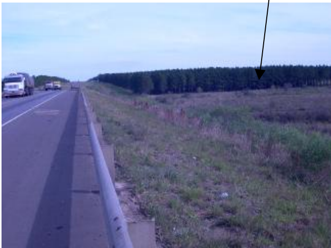
Foto N° 5: Alto Nivel Cruce Vías FFCC km. 267,95
